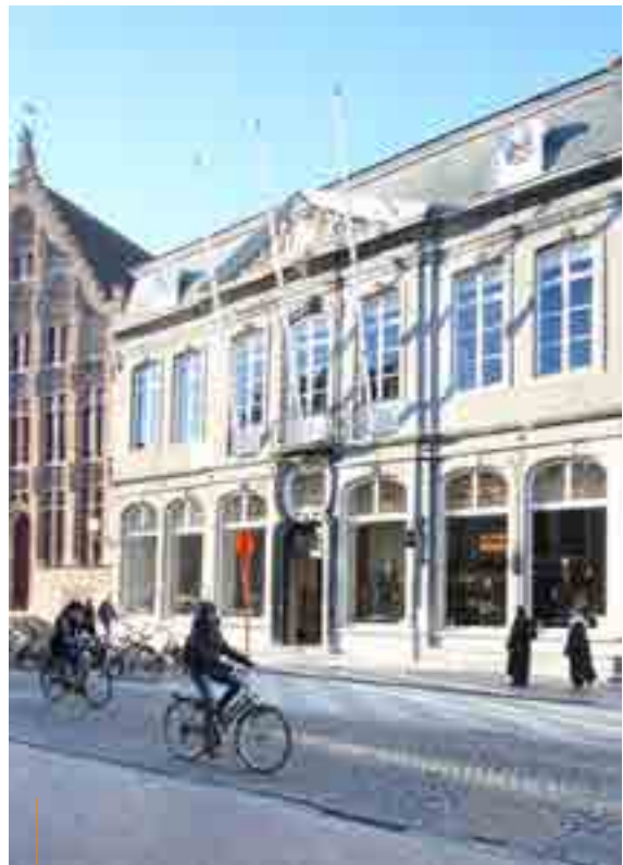
Bruges, Steenstraat - 941 m 2
