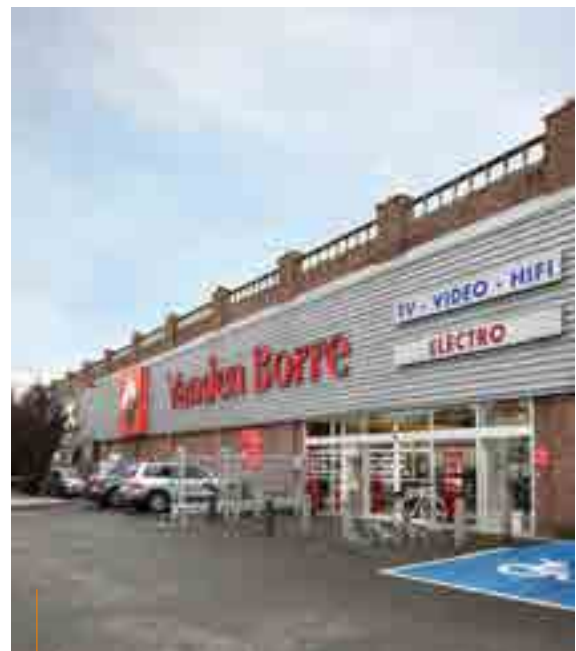
Bruxelles, chaussée de Louvain - 2.964 m 2
